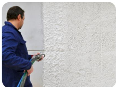
Aplicación del Mortero Thermolev ECO
